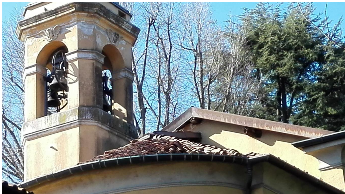
foto n. 12 : copertura (vista da Est)
