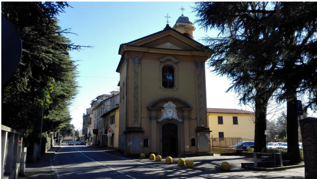
foto n. 1 : vista da Nord-Ovest
